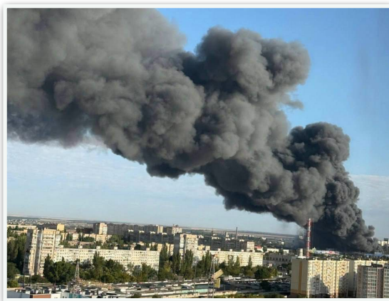
Zerstörung eines Baumarktes in unserem Stadtteil nach Drohneneinschlag
